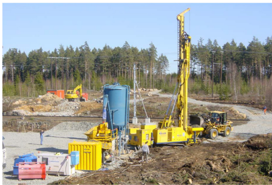
Figura 12. Ejecución de columnas de grava en Frövifors, Suecia.
