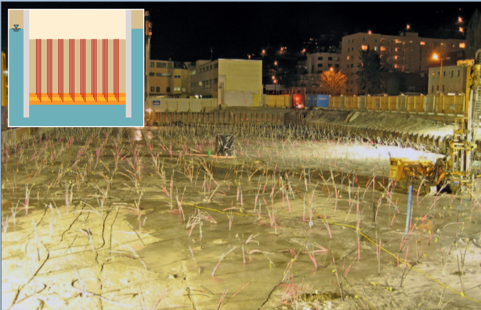
Tapón de fondo mediante inyecciones de silicato
