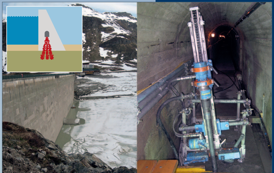
Inyecciones de consolidación en presas
