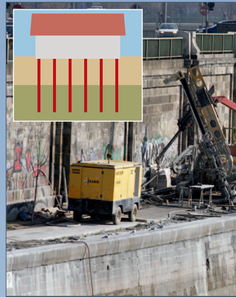
Rehabilitación mediante micropilas
