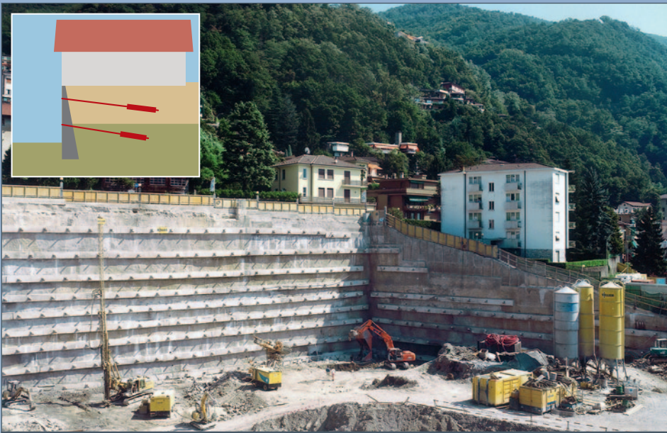
Contención de excavación con anclajes
