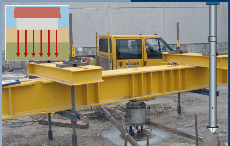
Ensayo de carga a tracción en micropilotes
