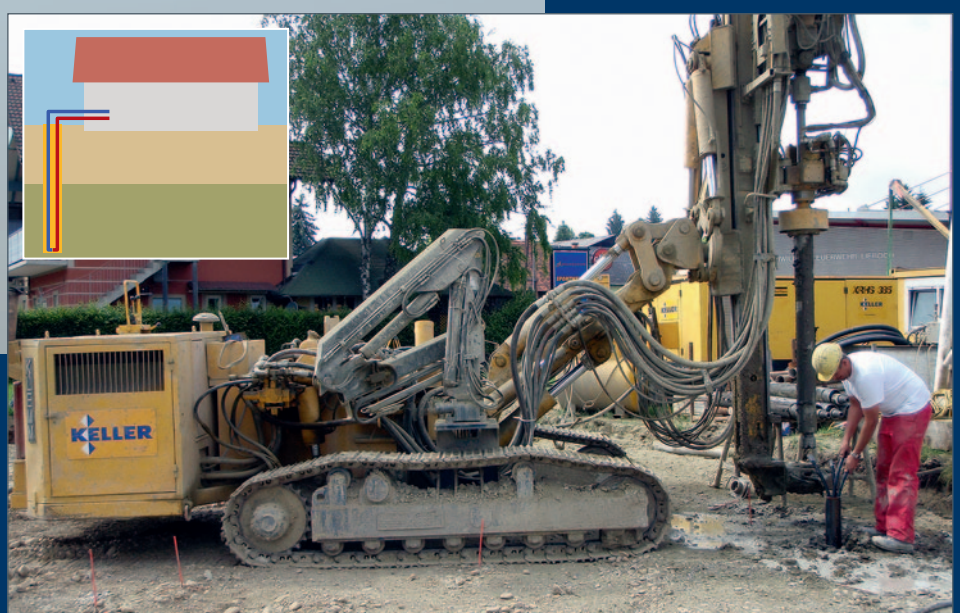
Perforaciones profundas para la instalación de equipos geotérmicos
